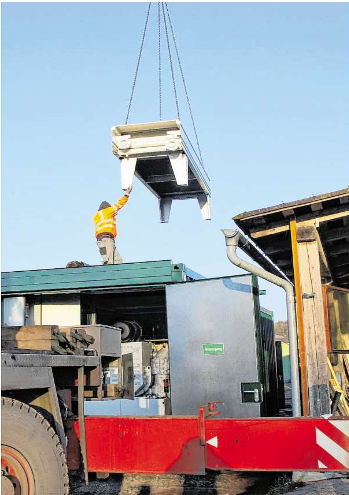
Unser Bild zeigt den Moment, als der Notkühler auf dem BHKW aufgesetzt wird. In den kommenden drei Monaten sollten die Reparaturen soweit fortgeschritten sein, dass die Anlage wieder im Normalbetrieb laufen kann. FOTOS: STEFANIE BRANTNER
